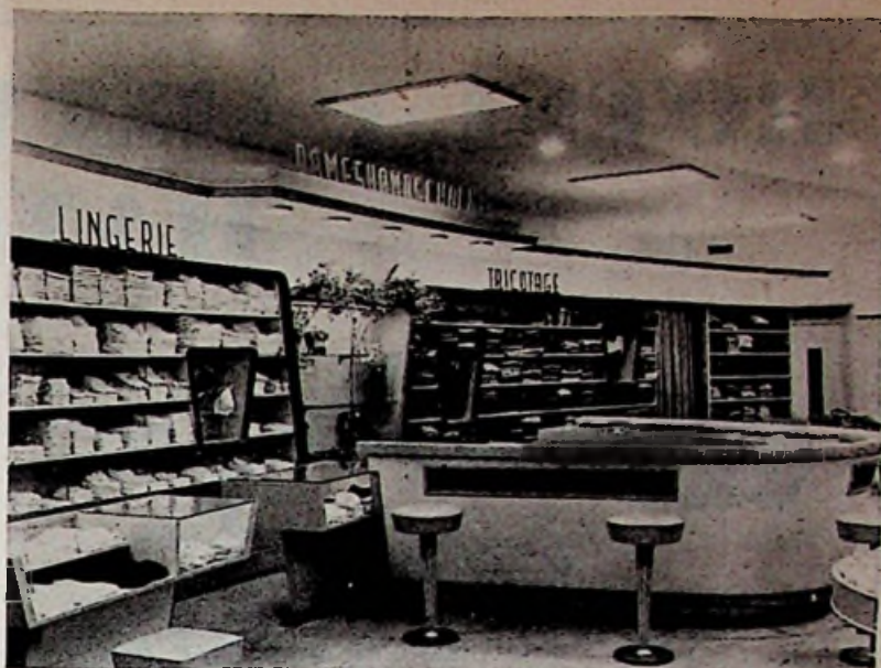
Afb. 4 Ingebouwde verlichting met koofverlichting. Verlichtingssterkte 450 lux.
