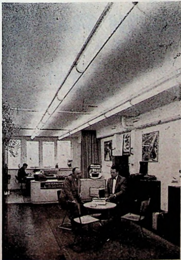
Afb. 5. Winkel van de kantooromachinehandel fa. P. Schrevel te Rotterdam. Toegepast zijn rupslichtroosterarmaturen, welke bijzonder geschikt zijn voor plafondmontage. Verlichtingssterkte 300 lux,
