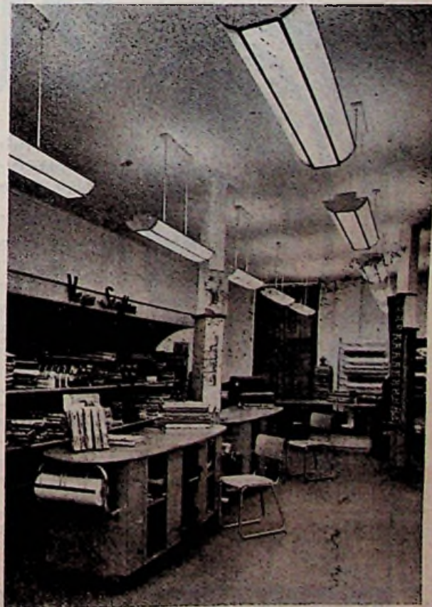
Afb. 8. Verkoopruimte VEGA, Middelburg. Pendelmontage met luxe armaturen. De goede lichtkleur is bereikt d.m.v. menging van fluorescentielampen „daglicht” en „warmtint”. Verlichtingssterkte 250 lux.
